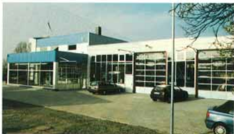
Die Fahrzeugannahme als Durchfahrstand, die Werkstatteinfahrt und das Tor für den Nutzfahrzeugstand
