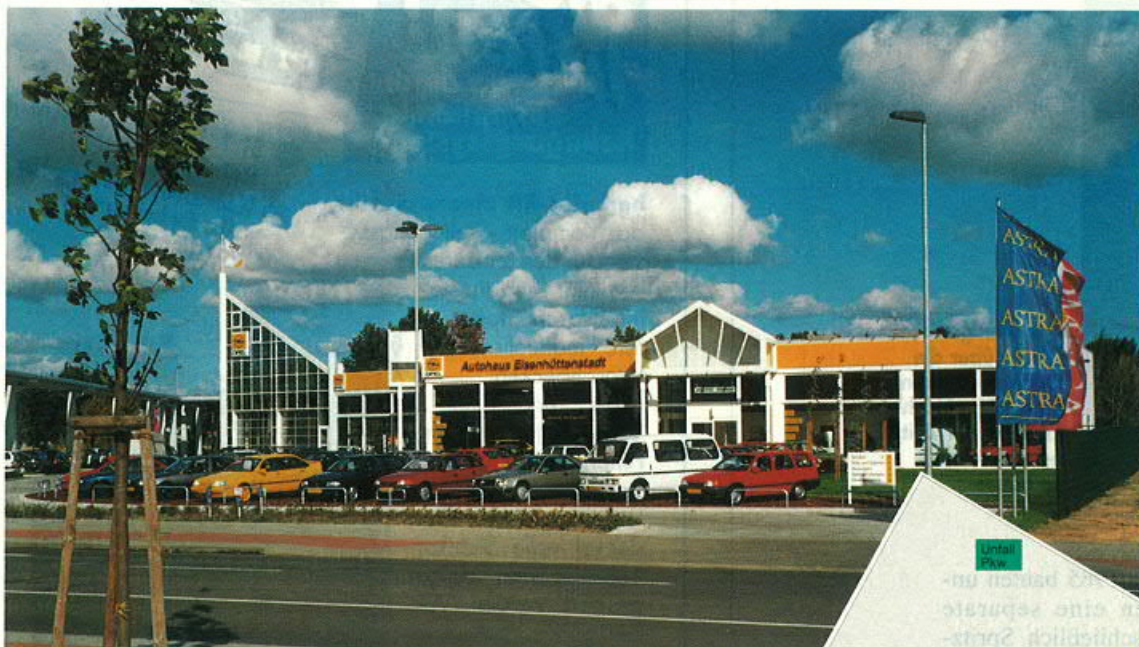
Ein kompletter Neubau wurde in Eisenhüttenstadt realisiert: Markant dabei vor allem der Annahmeturm (links): 15 Meter hoch mit verspiegeltem Glas
