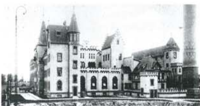
Nordansicht des Städtischen Elektrizitätswerkes um 1901
