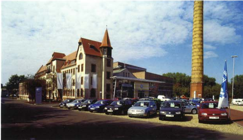
Nordansicht Autohaus August 2002
