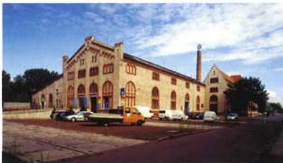
Südensicht der 1913 erweiterten Maschinenhalle; heute Zugang zur Reparaturannahme.
